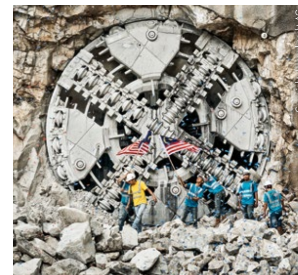
Weltweit bohren sich Tunnelvortriebsmaschinen durch die unterschiedlichsten Gesteinsarten und bahnen so neue Wege.
